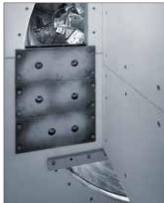
Öffnung im Kopfstück mit Segment-Stauwehr und zusätzlicher Bodenentleerung
